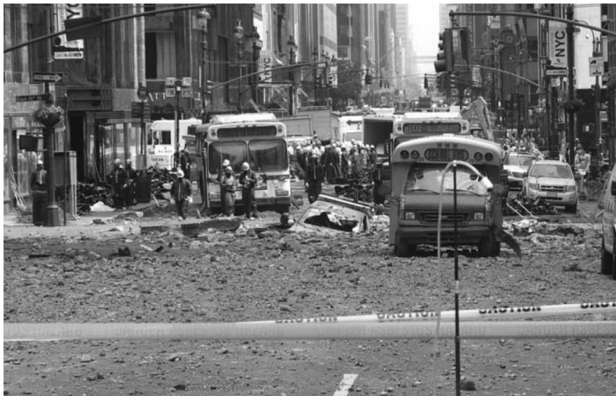
figuur 1. Explosie ondergrondse stoomleiding in New York (2008) waarbij een krater ontstond van ruwweg 10x10x5 meter
