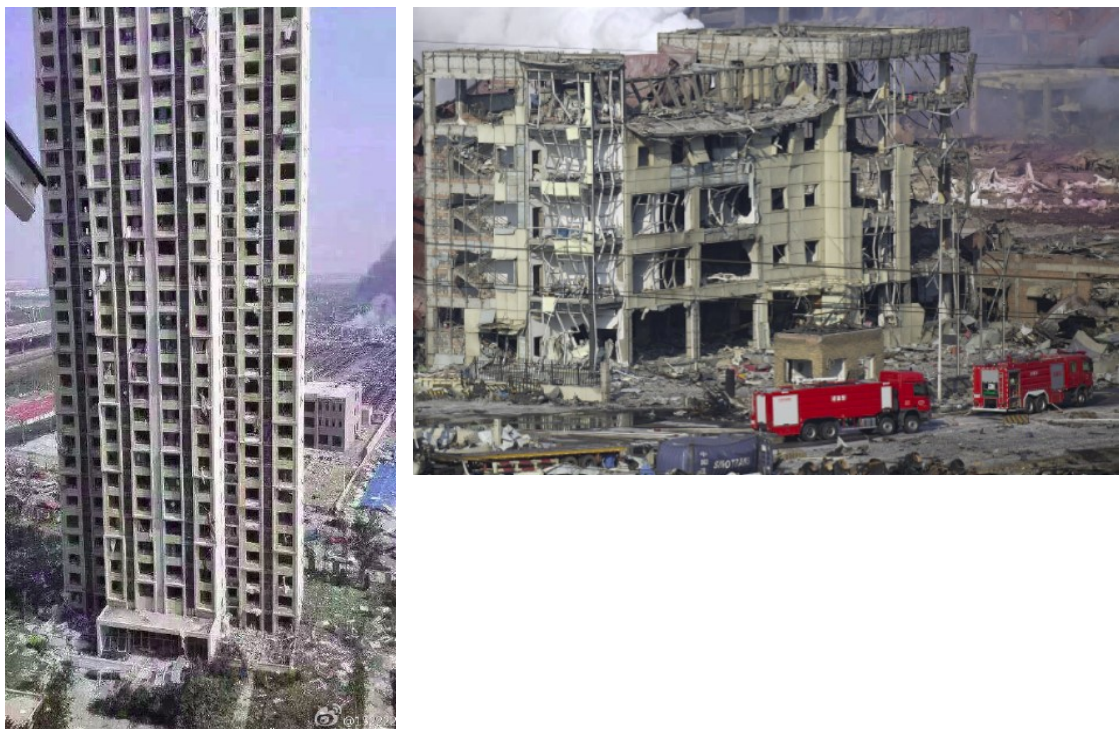
Figuur 8. Typische schadebeelden door explosie ca. 0.1 bar (links) en ca. 1 bar (rechts) [3]
